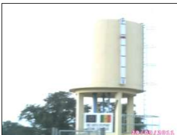
Forage solaire à Doulouyabé
